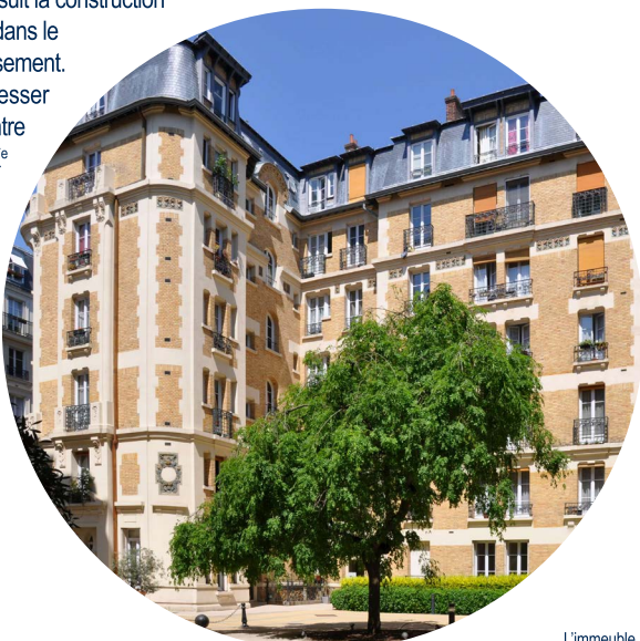
L'immeuble du 63-65 rue de l'Amiral Roussin (XV e arrondissement), construit en 1907
